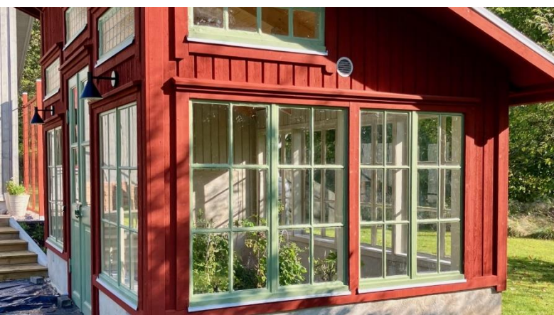
Nybyggnation av växthus och ateljé
