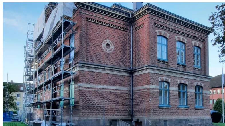
Renovering av skolbyggnad
