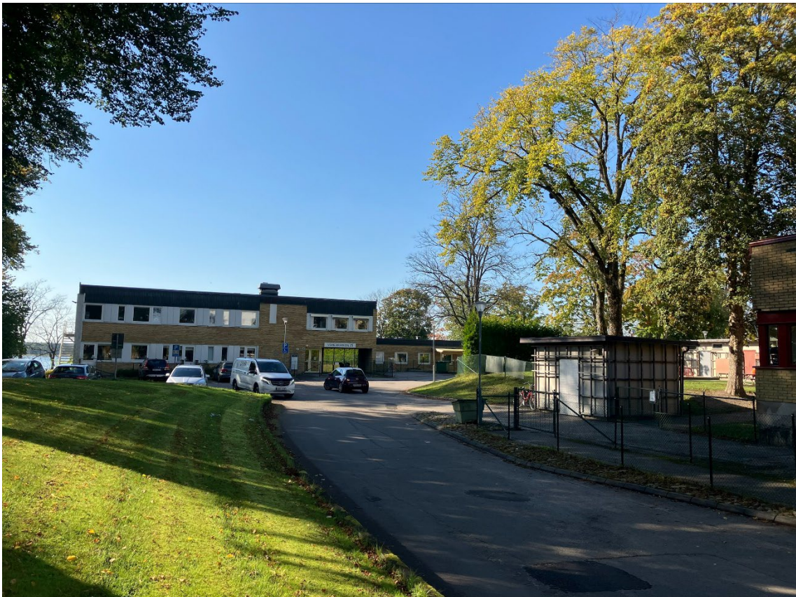
Vänerparkens bebyggelse och utemiljö där den möter Vassbotten. En del av trafiksituationen inom planområdet visas i bild. Bilden är tagen mot väster, från en plats strax öster om förskolorna i sydvästra planområdet.
