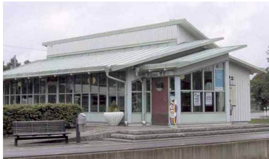
Ny stationsbyggnad [8]Foto: Jernhusen
