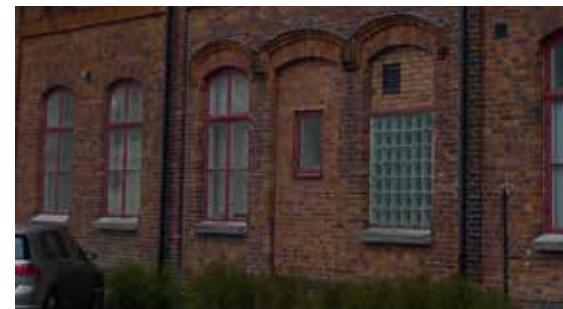
Den gamla huvudentrén kan öppnas igen
