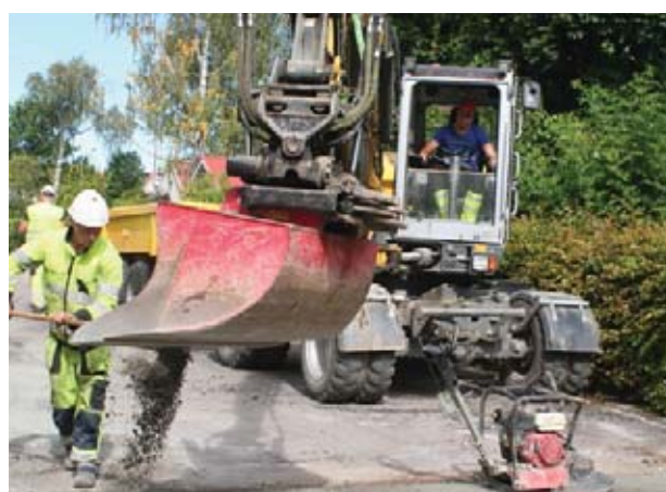
Fiberutbyggnad pågår, augusti 2016.
