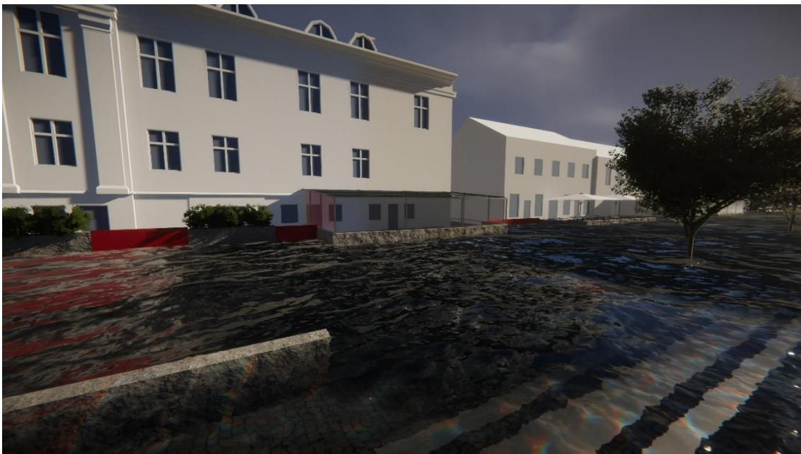
Bilden illustrerar hur ett översvämningskydd närmre fasad hade kunnat utformas. I rött syns tillfälliga skydd att komplettera de permanenta med.
