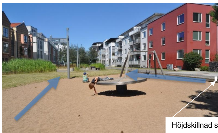
Figur 9 Ett nedsänkt stråk för sekundär rinnväg, blå pilar visar vattnets flödesriktning, höjdskillnaden ses till höger. Vid torrväder används ytan som plats för lek och rekreation.
